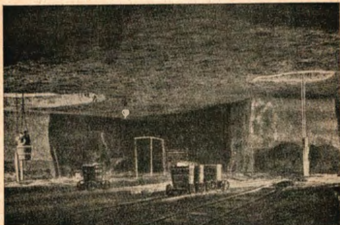
Nortwichin suolakaivos. Louhittu suola kuljetetaan saantipaikantansa kaivoksen aukolle raiteita pitkin.
