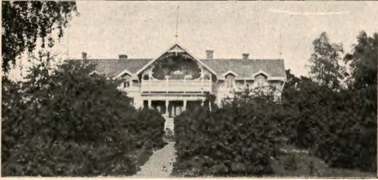
Liuksiala Roineen puolelta. Nykyinen päärakennus.
