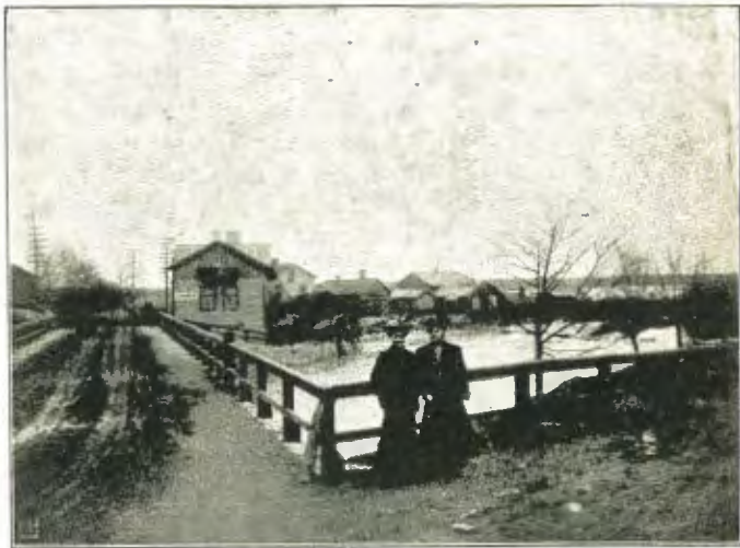
Vanhan kaupungin silta Vantaan yli.
